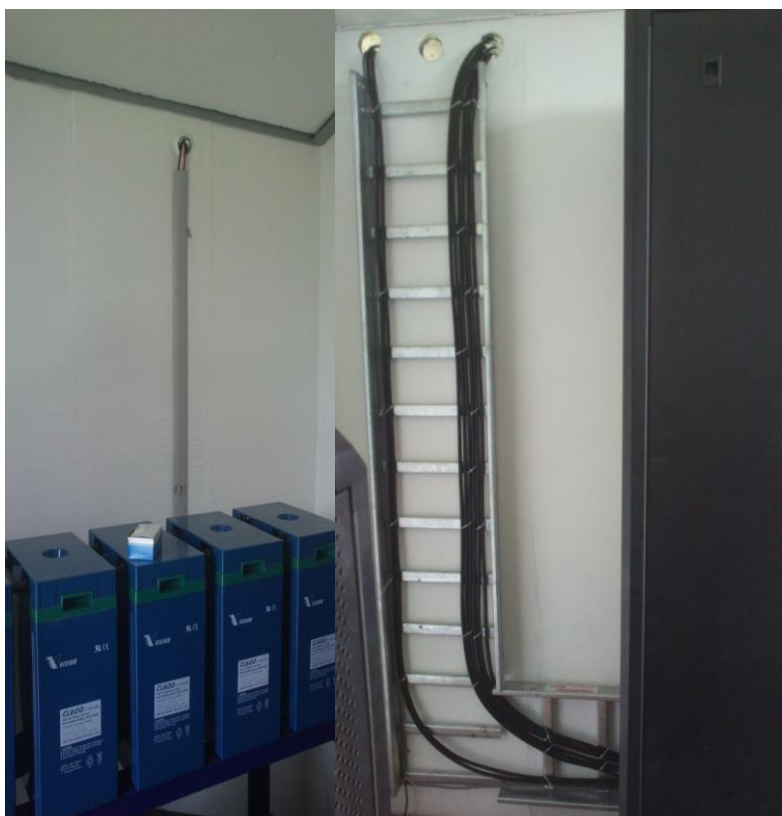
Figura 44. Estación repetidora CIELO ROTO, baterías y cableado de RF.
