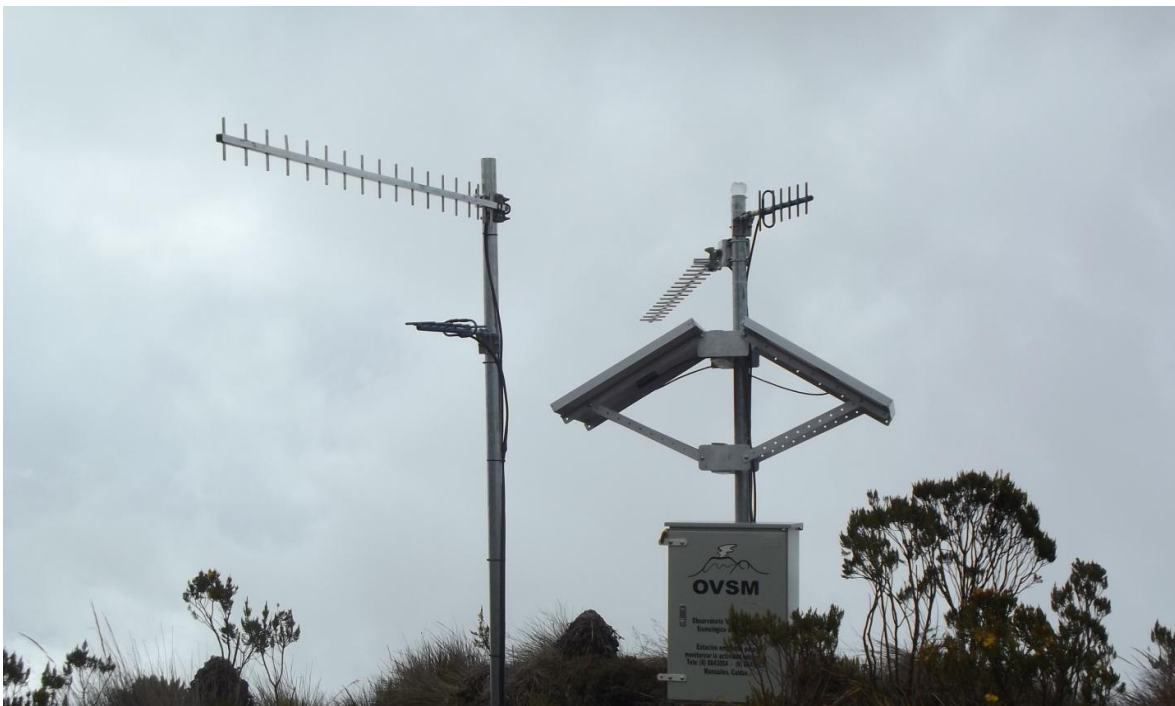
Figura 2. Nuevo repetidor EL CAMION con el nuevo tipo de estructuras de paneles solares.
